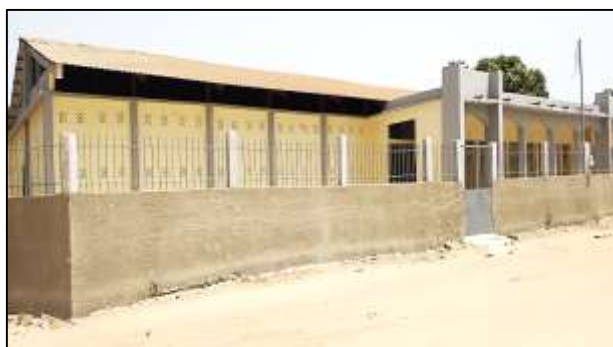
Photo 7 : Bâtiment du marché de la commune de Thionck-Essyl
